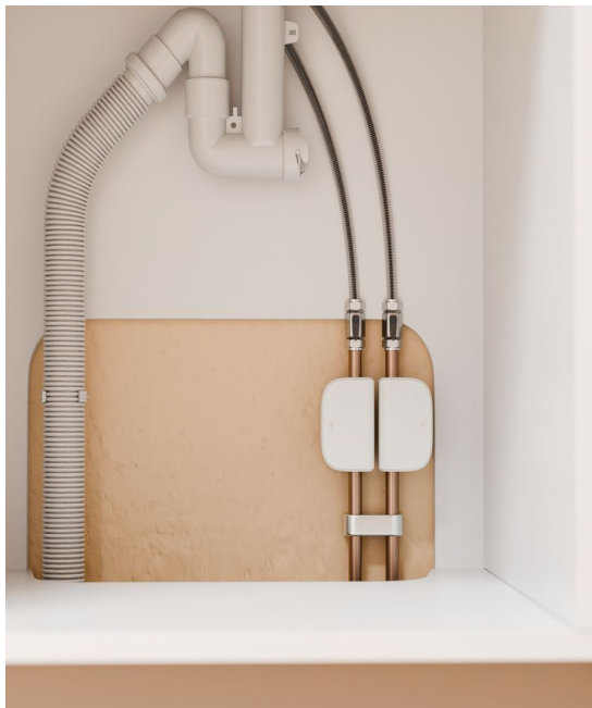
Image : exemple de deux Water Grip installés sur les tuyaux d'eau sous l'évier de la cuisine.
